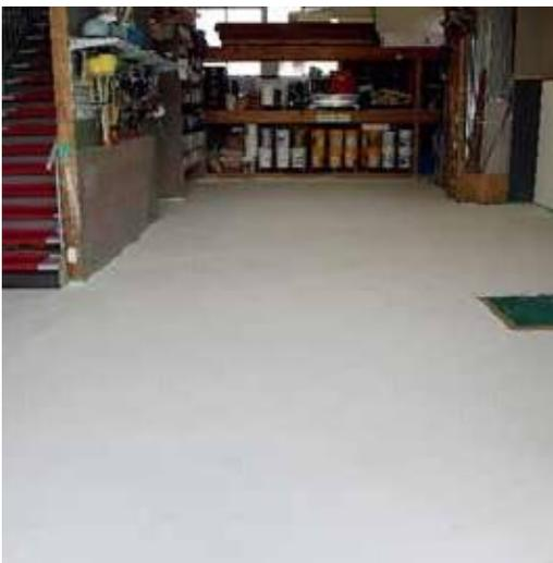
既に塗り付けてあるレギュラーの骨材の頭にコテを当て、骨材をこする音が聞こえるように施工をして下さい。
